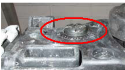
Vis de purge partiellement retirée
